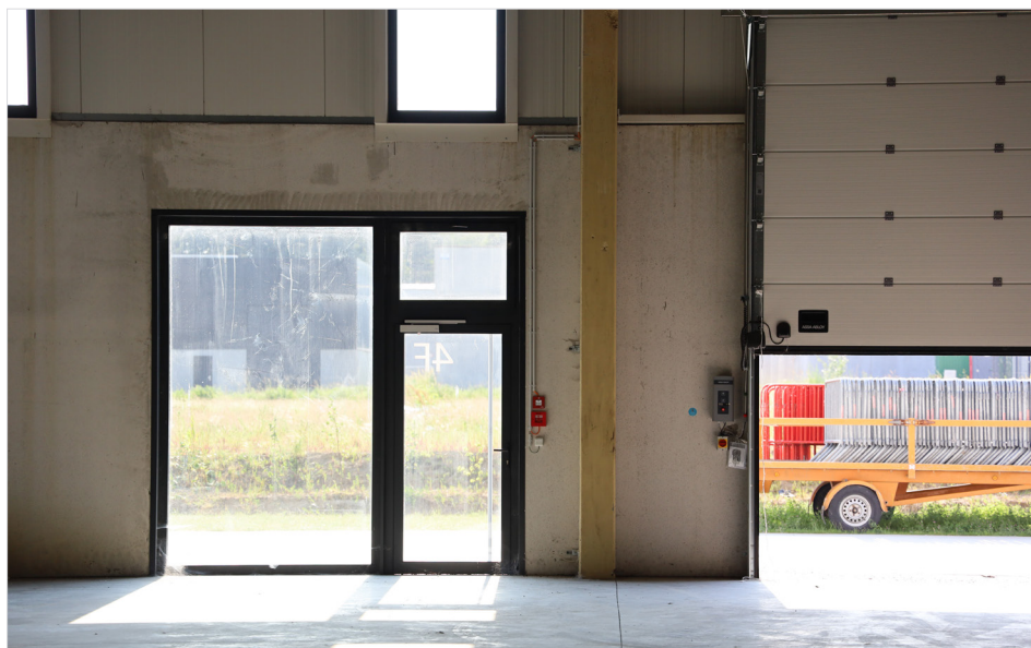
Binnenzijde unit: schrijnwerk
