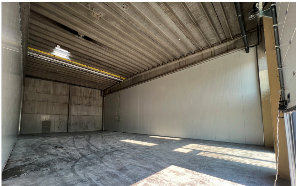
Binnenzijde unit: afscheidingen in zelfdragende sandwichpanelen
