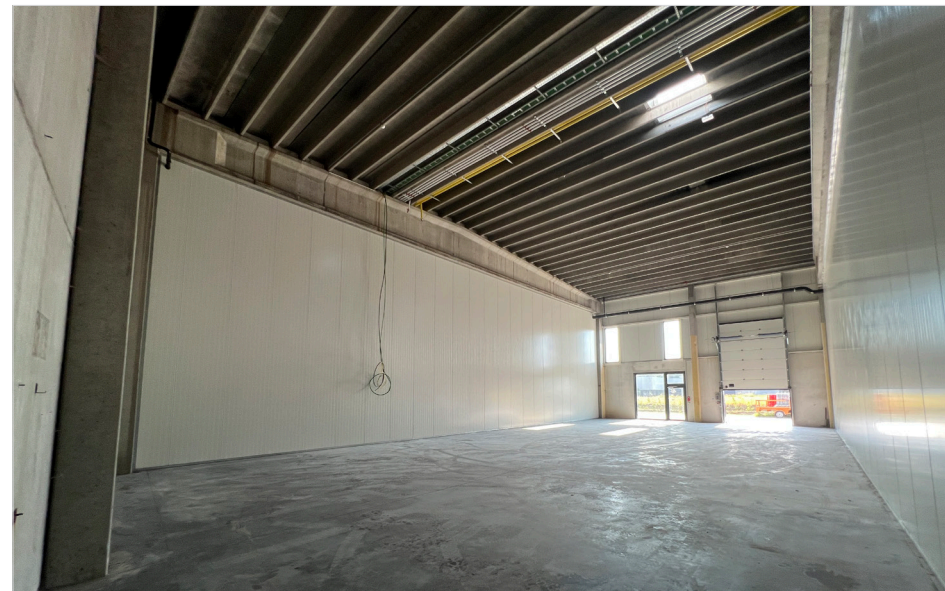
Binnenzijde unit: vloer in gepolierd beton
