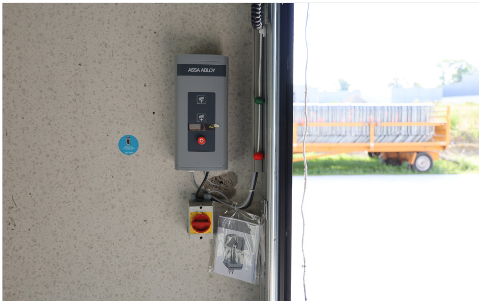
Binnenzijde unit: bediening sectionaalpoort
