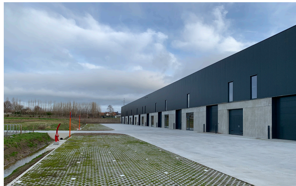
Buitenzijde: parkings in grasdallen en laad- en loszone in gepolierd beton
